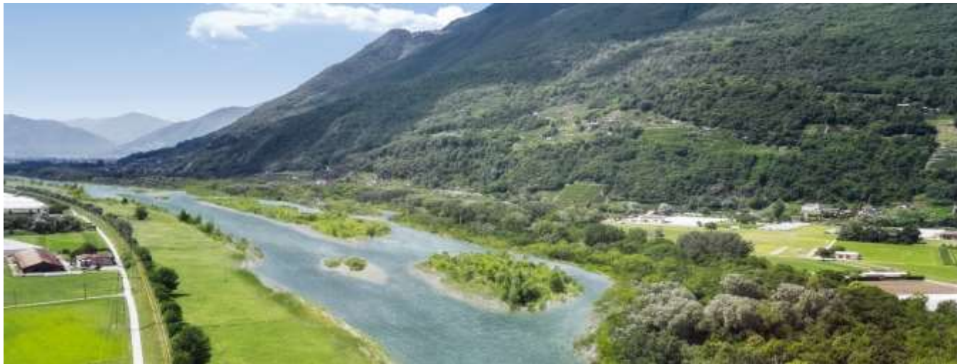
Sistemazione idraulica e rinaturazione Fiume Ticino, 2020
