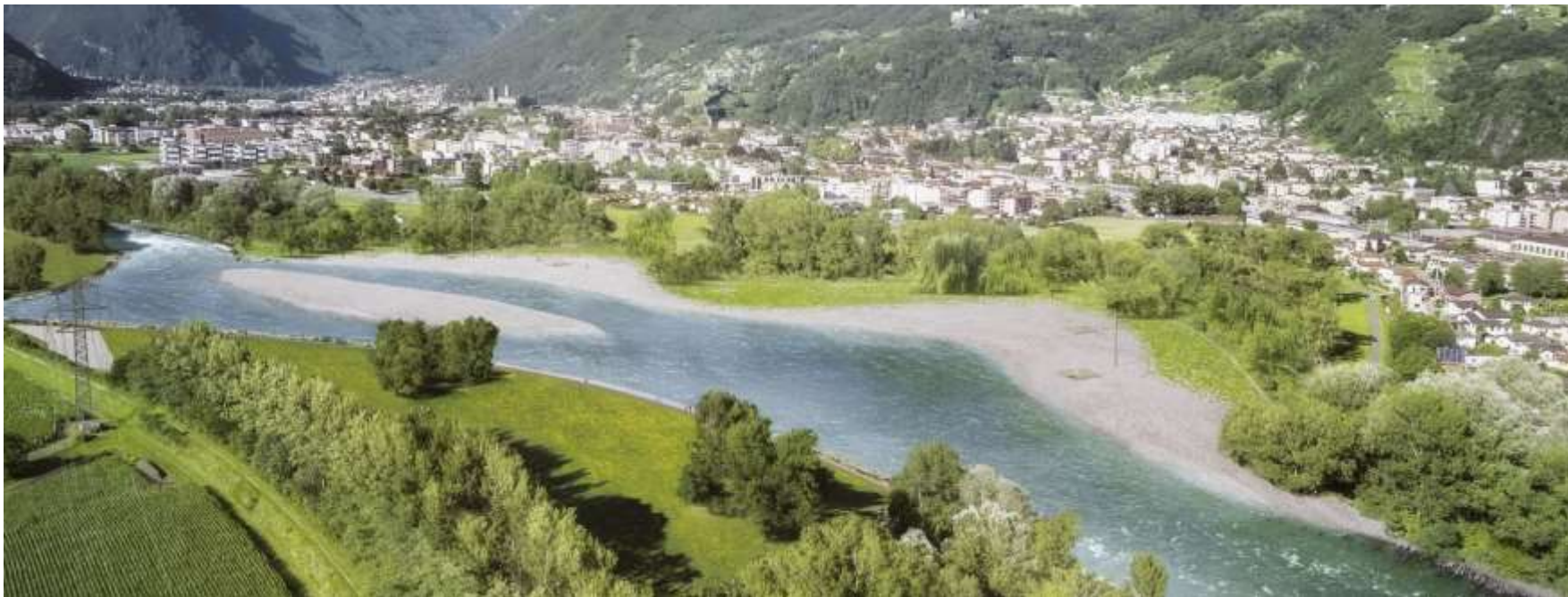
Sistemazione idraulica e rinaturazione Fiume Ticino, 2020
