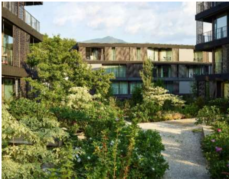
SORENGO, QUARTIERE CASARICO
